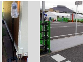
仮設スロープの設置
